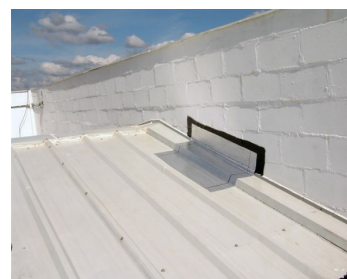
Reparo em alvenaria
