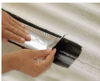
Reparo em telha de fibrocimento
