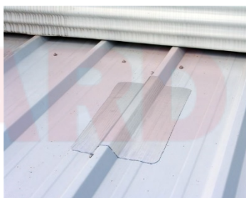
Reparo na sobreposição de telhas
