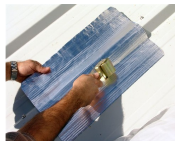
Reparo na sobreposição de telhas
